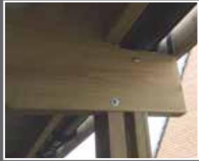
Bandeau périphérique avec gouttière intégrée
