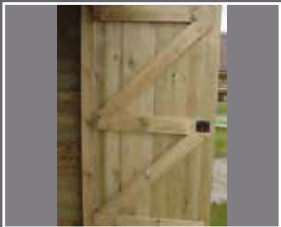
Porte en Z montée sur un bloc bâti
