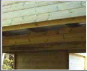
Fermes pré-usinées assemblées et collées
