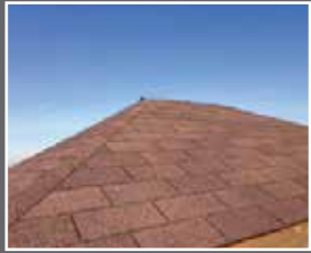
Toiture 4 pans, couverture Shingles
