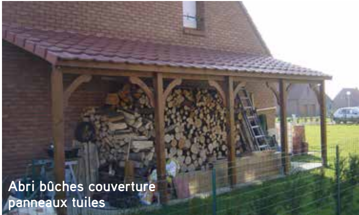
Abri bûches couverture tuiles plates
