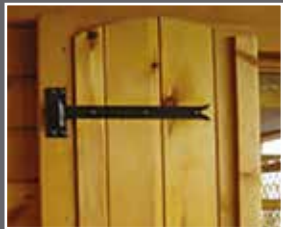
Volets en 22 mm montés sur gonds et penture
