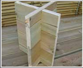
Construction par emboîtement
