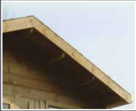
Avancée de toit de 50 cm
