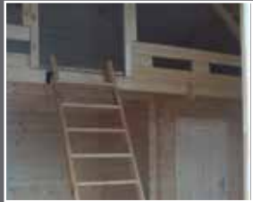
Mezzanine avec échelle de meunier
