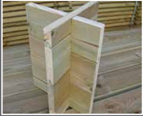
Construction par emboîtement
