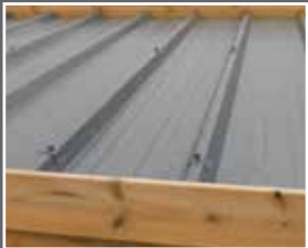
Toit plat en bac acier
