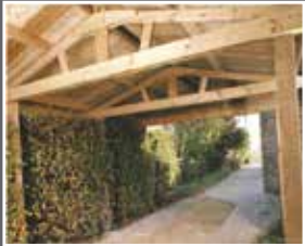
Ferme de soutien pour toit 2 pentes
